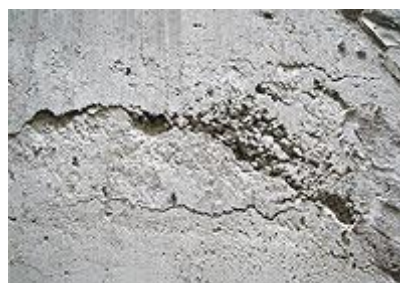
Falha de concretagem/vibração do concreto - Falha de concretagem, representada por má vibração, aumenta a porosidade do concreto e abre caminho para ataque do CO2 atmosférico
