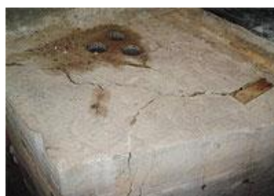
Falha de concretagem/vibração do concreto - Falha de concretagem, representada por má vibração, aumenta a porosidade do concreto e abre caminho para ataque do CO2 atmosférico
